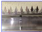
横引管に1本取付
